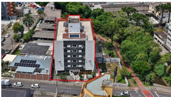
VISTA FACHADA DO CONDOMÍNIO
