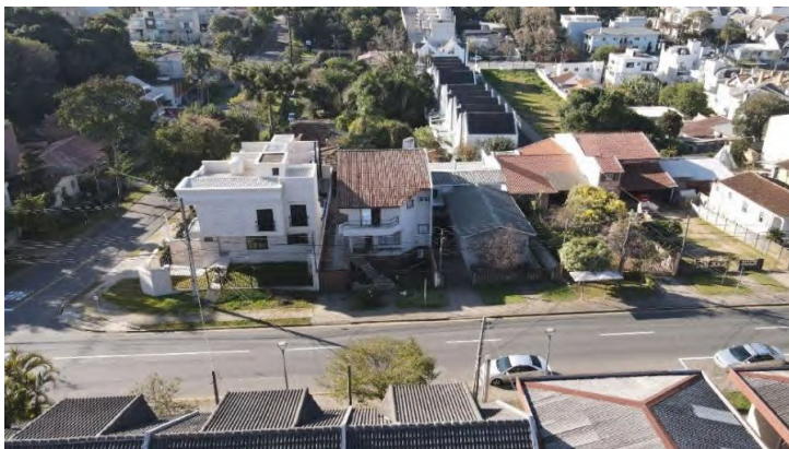
VISTA AÉREA DA FACHADA DO IMÓVEL
