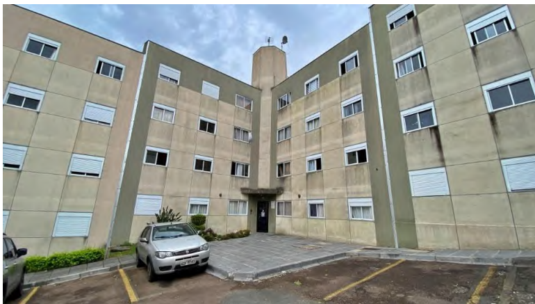
VISTA DA FACHADA DO BLOCO B-8
