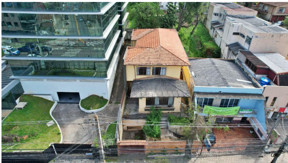
VISTA AÉREA DA FACHADA DO IMÓVEL
