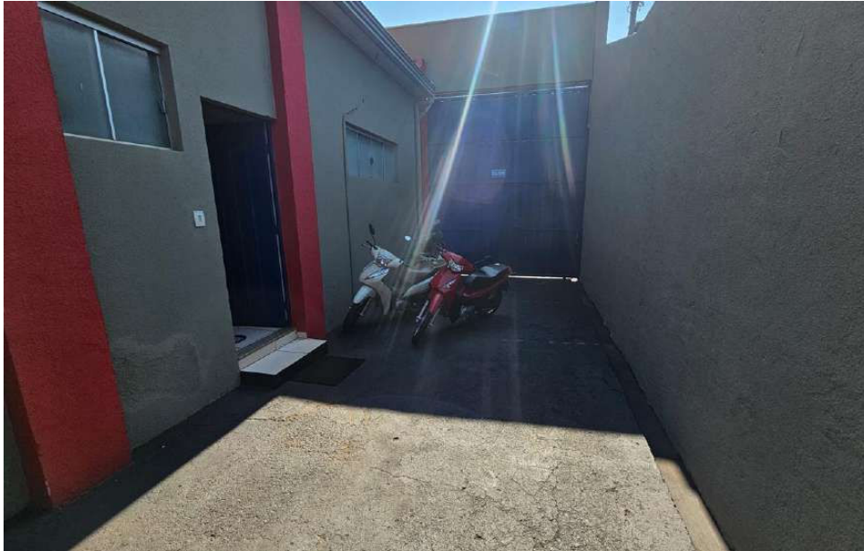
Corredor lateral que dá acesso ao depósito
