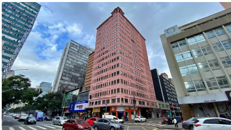
VISTA DA FACHADA DO EDIFÍCIO PEDRO DEMETERCO
