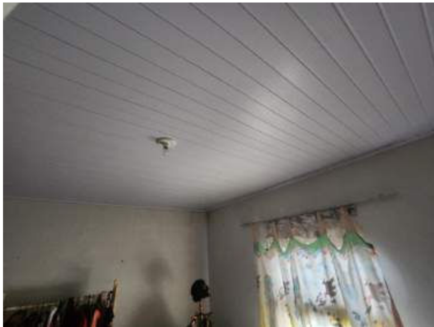
Foto 19: Detalhe, Forro PV (pavimento superior).
