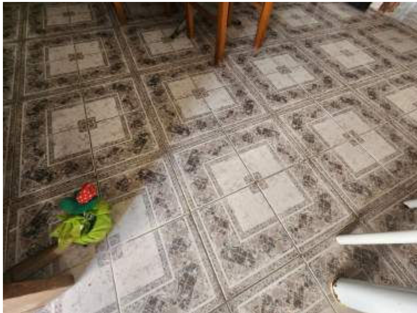
Foto 14: Detalhe, piso cerâmico.
