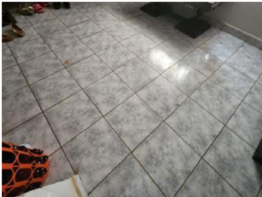
Foto 20: Detalhe, Piso cerâmico (pavimento superior).
