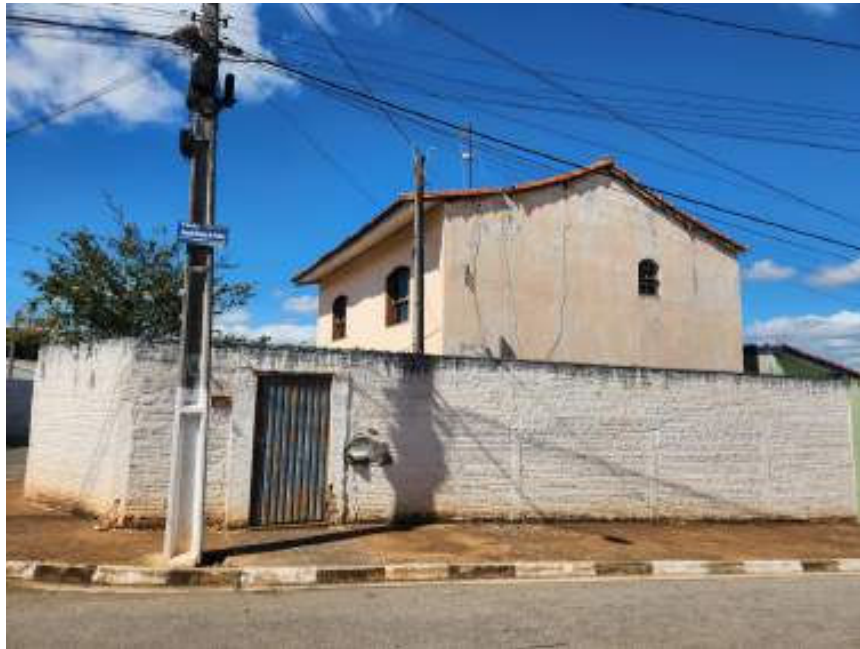
Foto 04: Vista Logradouro Rua Antônio Messias de Freitas.
