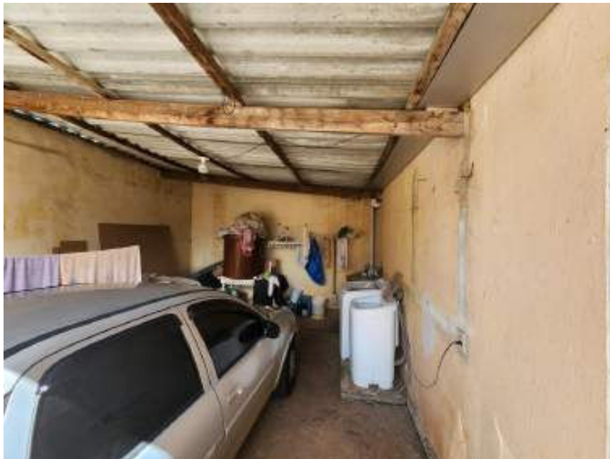
Foto 08: Garagem e Lavanderia.
