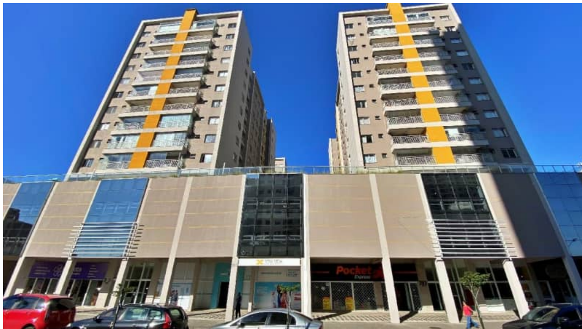
VISTA DA FACHADA DO CONDOMÍNIO – Frente para Av. Winston Churchill
