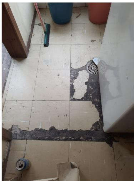
piso da área de serviço
