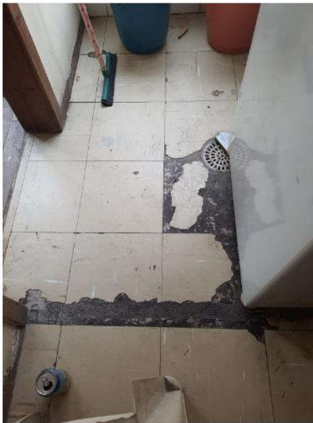
piso da área de serviço
