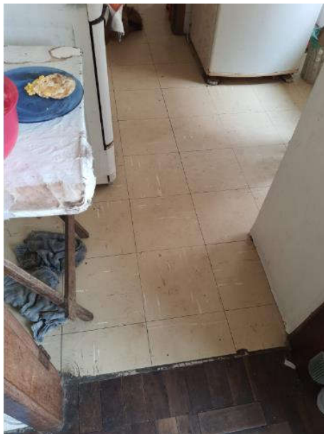
piso da cozinha
