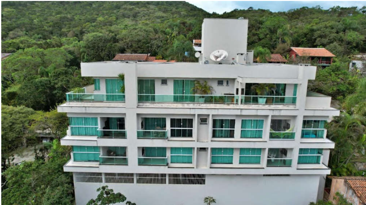
VISTA DA FACHADA DOS FUNDOS DO CONDOMÍNIO
