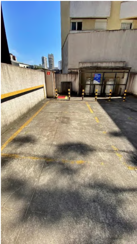
VISTA DA VAGA DE GARAGEM
