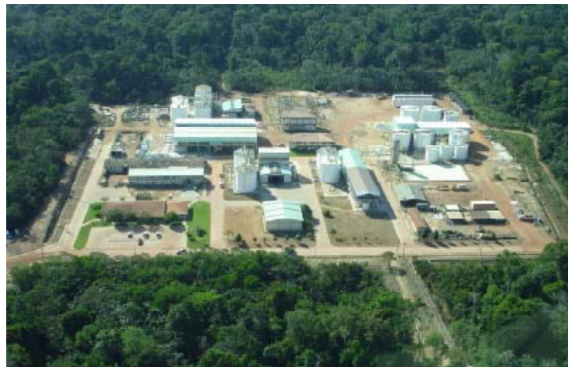
Foto 2 USINA DE BENEFICIAMENTO DA PPSA
