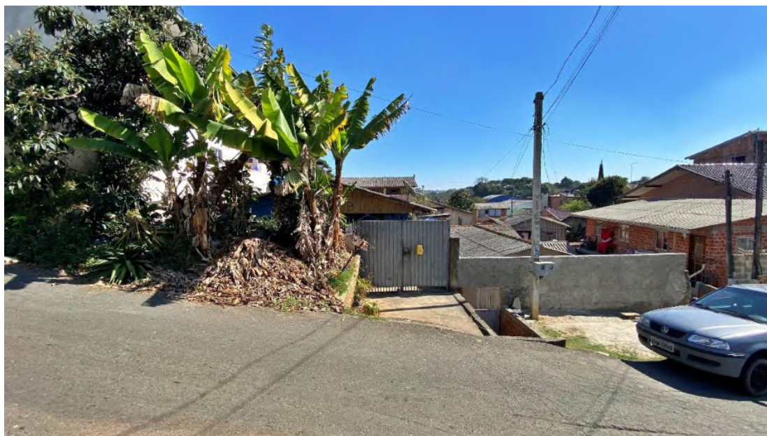
VISTA DA FACHADA DO IMÓVEL – FRENTE PARA RUA CRUZEIRO DO OESTE
