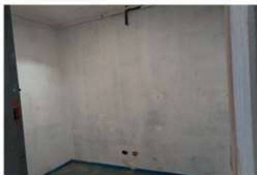
Foto 12 - Área construída - sala
