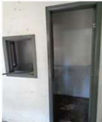
Foto 13 - Área construída - sala
