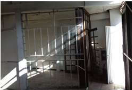
Foto 10 - Área construída próxima entrada
