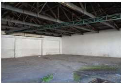
Foto 07 - Cobertura na frente do terreno
