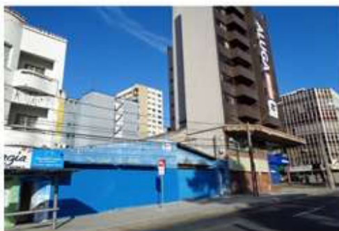
Foto 04 - Vista em direção a Rua Barão do Rio Branco
