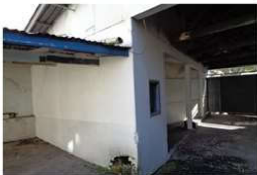
Foto 09 - Vista geral fundo área construída
