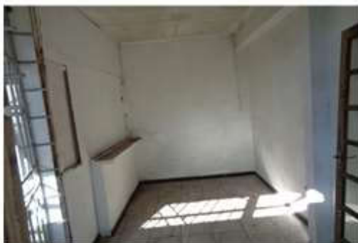
Foto 11 - Área construída - sala
