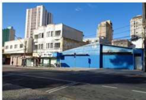
Foto 03 - Vista em direção a Rua Riachuelo
