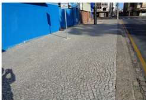
Foto 05 - Calçada em frente ao terreno
