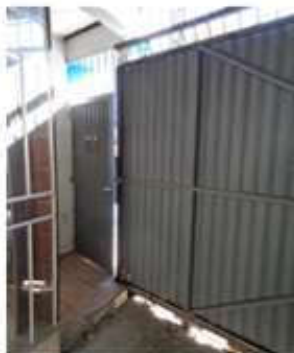
Foto 16 - Portões de entrada - metálicos
