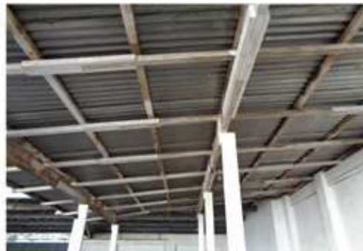
Foto 19 - Estrutura de madeira da área coberta
