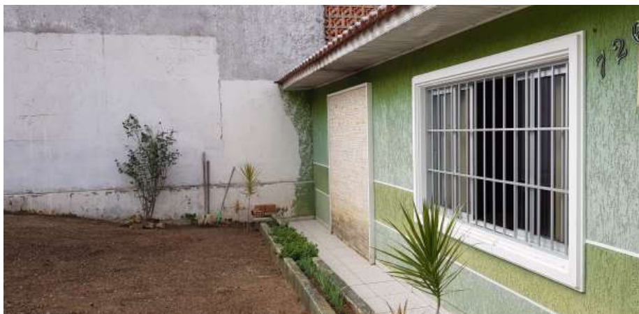
Fachada principal da residência.
