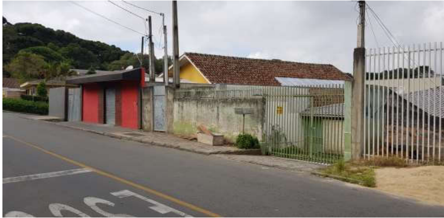
Imóvel avaliando com muro pintado na cor verde.
