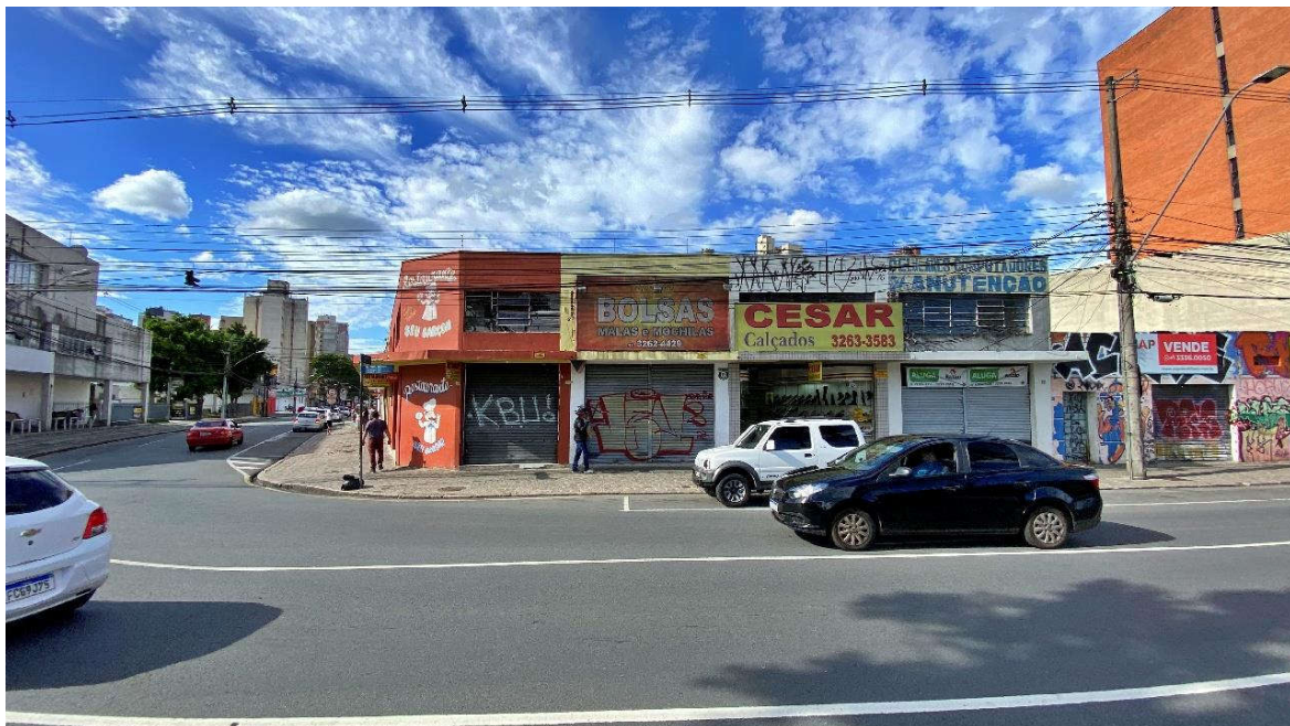
VISTA DA FACHADA PELA AV. PRES. AFFONSO CAMARGO
