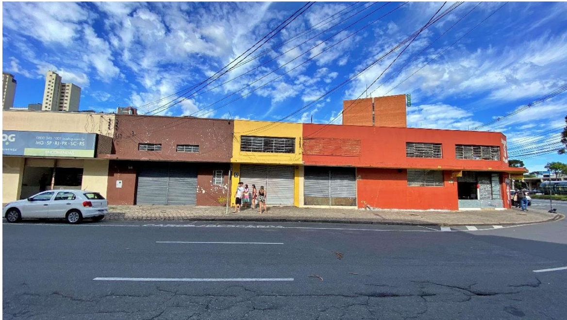
VISTA DA FACHADA PELA RUA DR. FAIVRE
