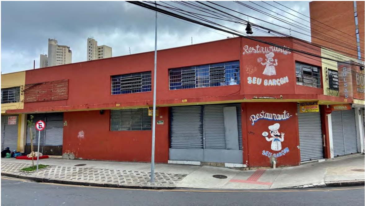
VISTA DA FACHADA PELA RUA DR. FAIVRE
