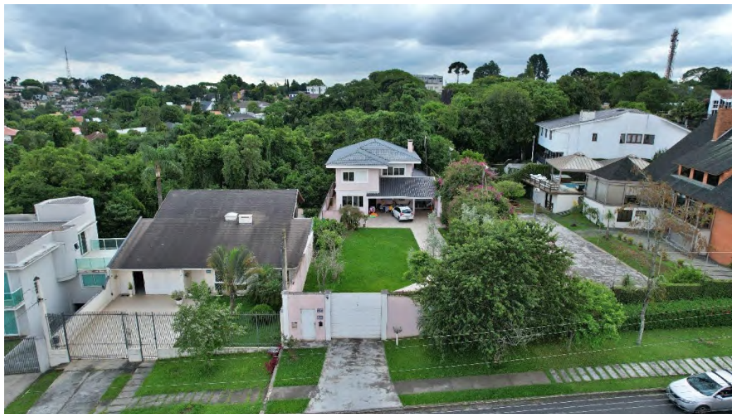
VISTA AÉREA DA FACHADA DO IMÓVEL
