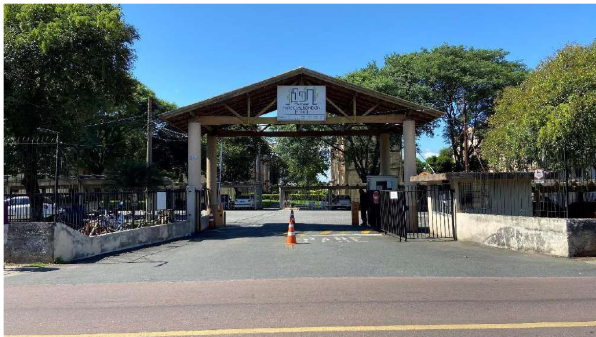
VISTA DA FACHADA DO CONJUNTO RESIDENCIAL
