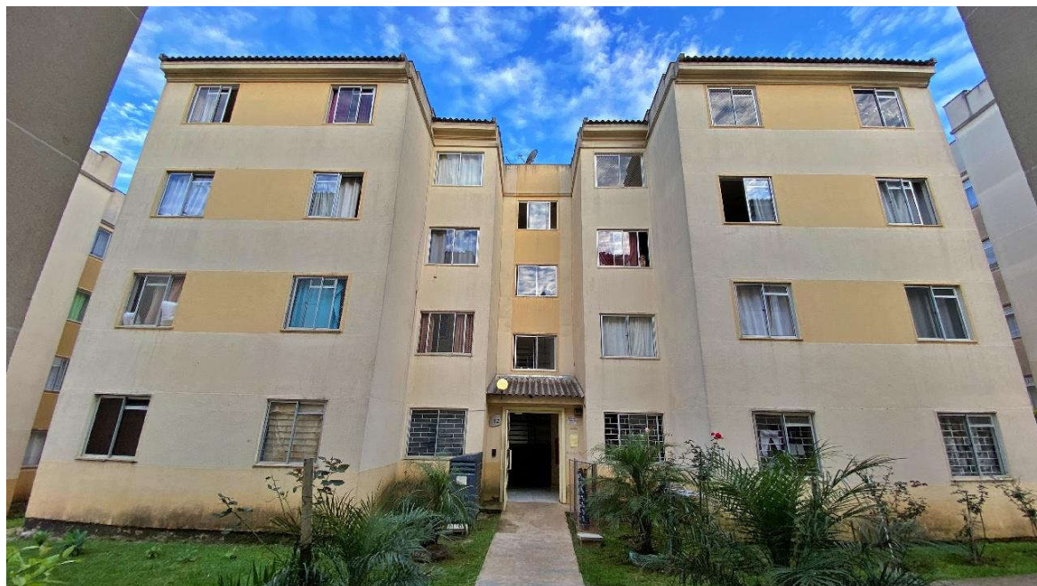
VISTA DA FACHADA DO BLOCO 12
