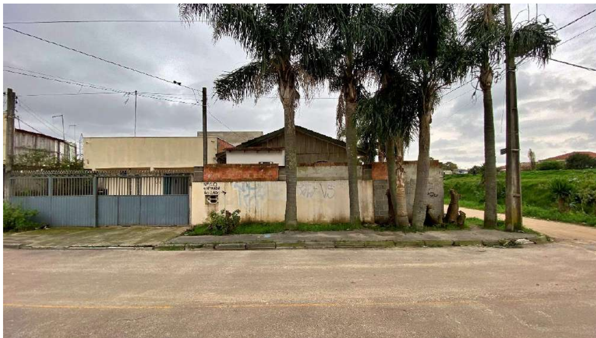
VISTA DA FACHADA DO IMÓVEL – RUA IVONE ESPÍRITO SANTO GARCIA
