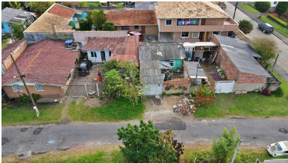
VISTA AÉREA DA FACHADA DO IMÓVEL
