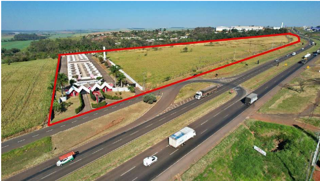
VISTA AÉREA DA FACHADA DO IMÓVEL
