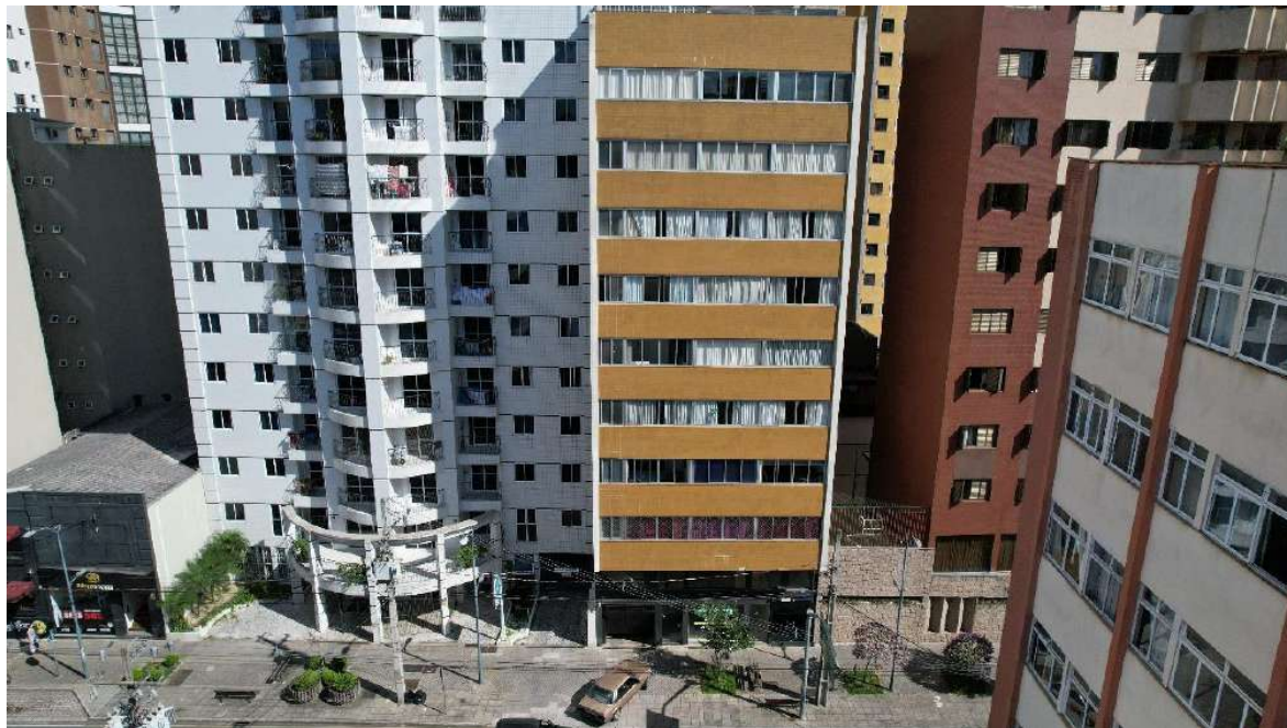
VISTA AÉREA DA FACHADA DO IMÓVEL
