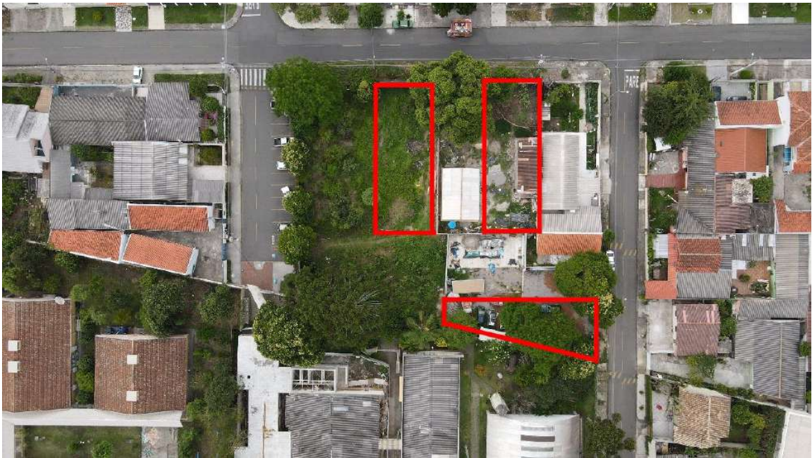
VISTA AÉREA DOS IMÓVEIS
