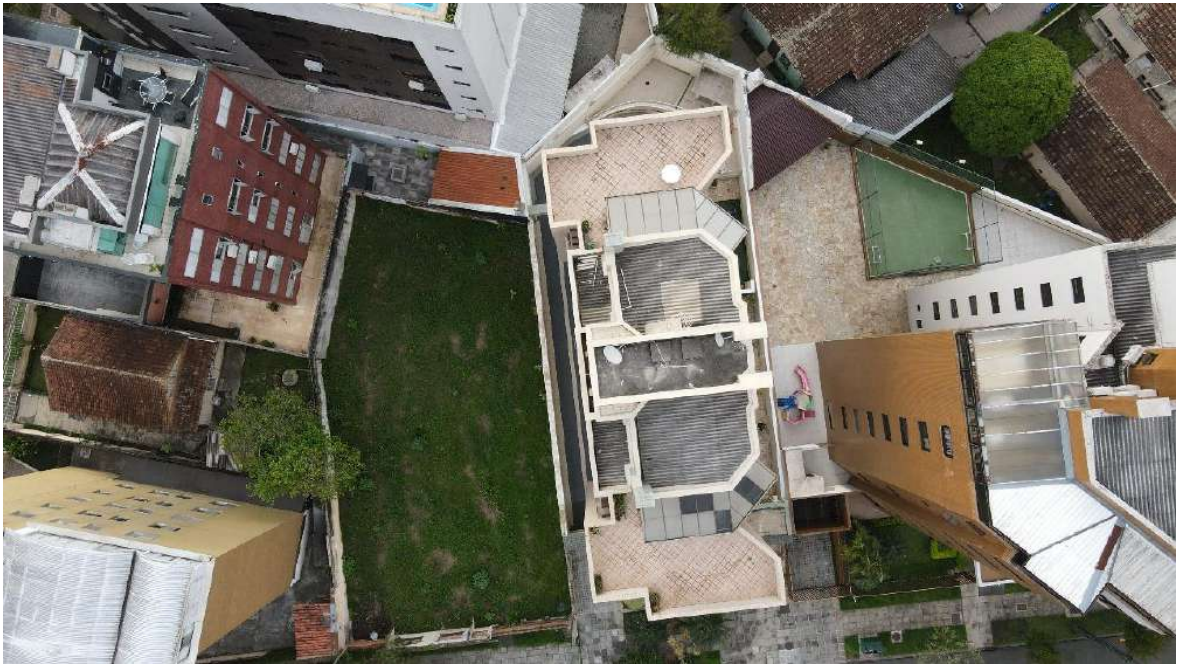
VISTA ÁEREA DO IMÓVEL
