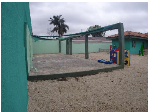
Vista do fundo do terreno da esquerda para a direita
