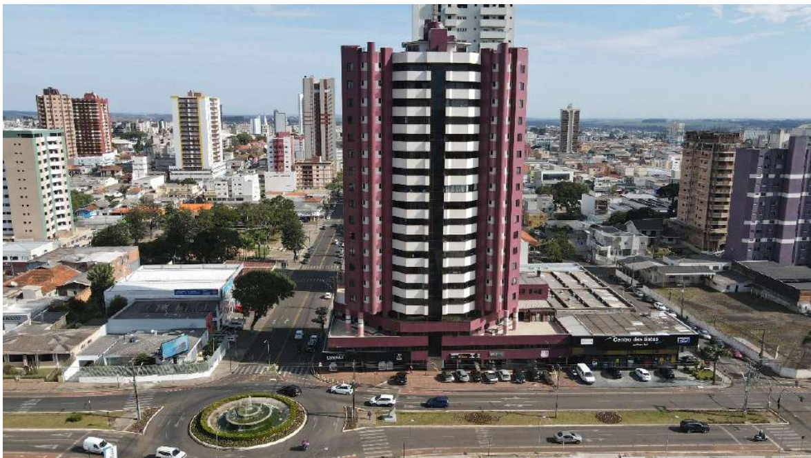
VISTA AÉREA DA FACHADA DO IMÓVEL
