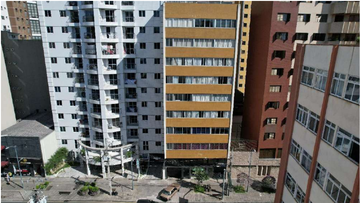
VISTA AÉREA DA FACHADA DO IMÓVEL
