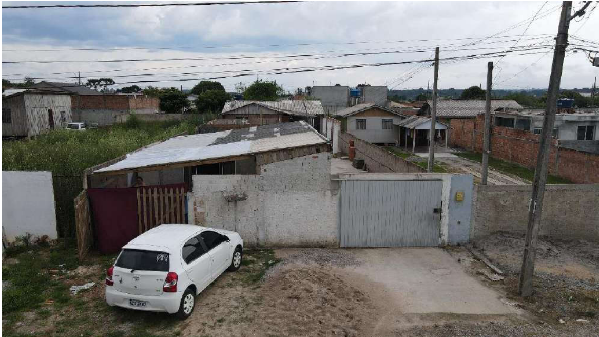
VISTA AÉREA DA FACHADA DO IMÓVEL
