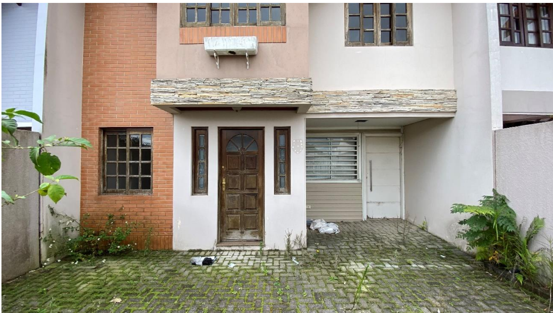
FACHADA 1º PAVIMENTO
