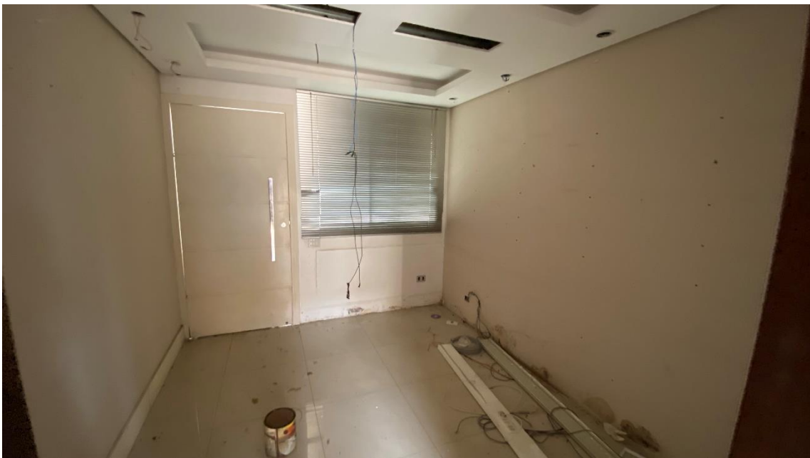
SALA/ESCRITÓRIO – ESTE LOCAL ERA UMA GARAGEM COBERTA E FOI TRANSFORMADO EM SALA
