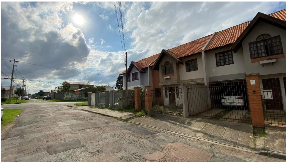
VISTA FRONTAL DA DIREITA PARA A ESQUERDA DE QUEM DA RUA OLHA O IMÓVEL
