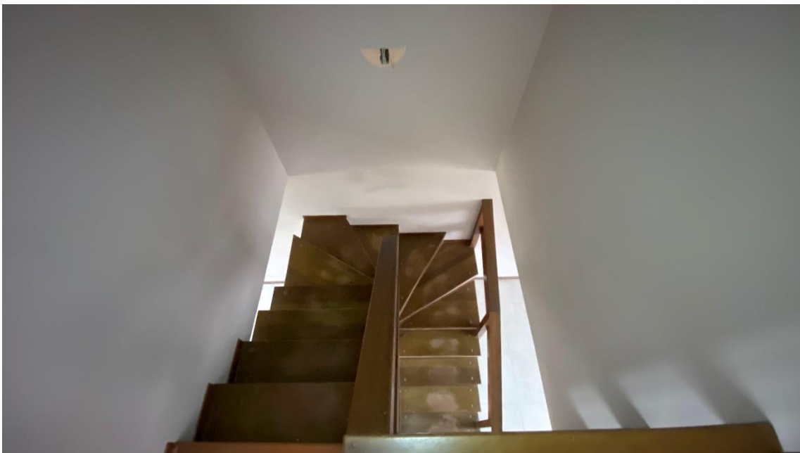
ESCADA DE ACESSO AO PAV.SUPERIOR – VISTA DE CIMA PARA BAIXO
