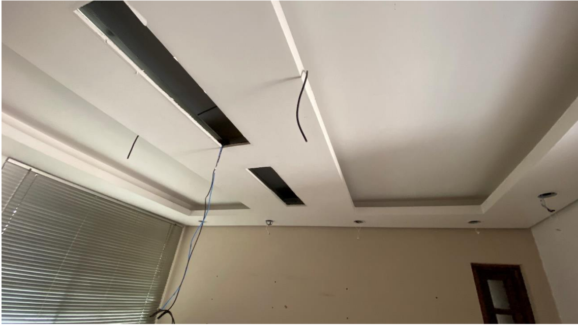
SALA/ESCRITÓRIO – TETO COM REBAIXO DE GESSO
