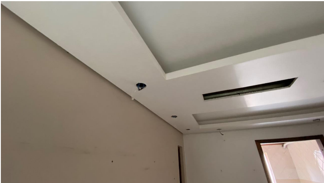
SALA/ESCRITÓRIO – LUMINÁRIAS FORAM REMOVIDAS
