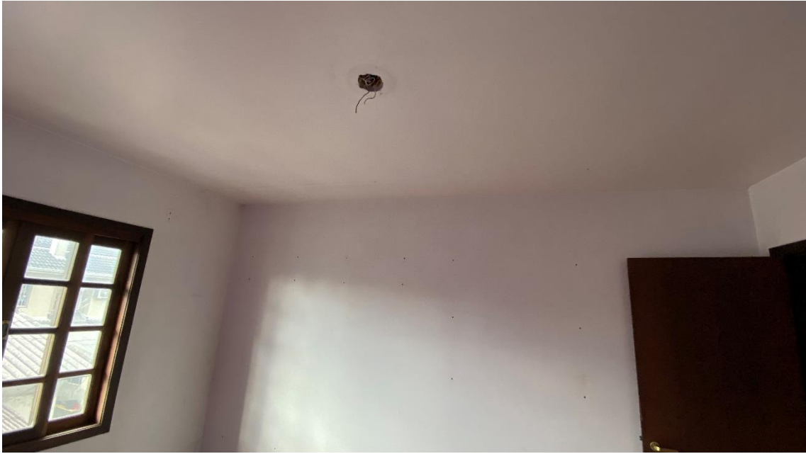
QUARTO FUNDOS – SEM LUMINÁRIA / TETO EM LAJE
