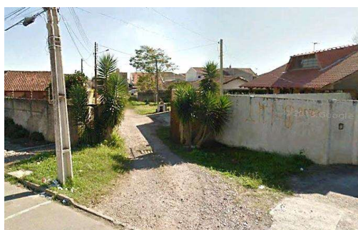
Entrada do conj. residencial
