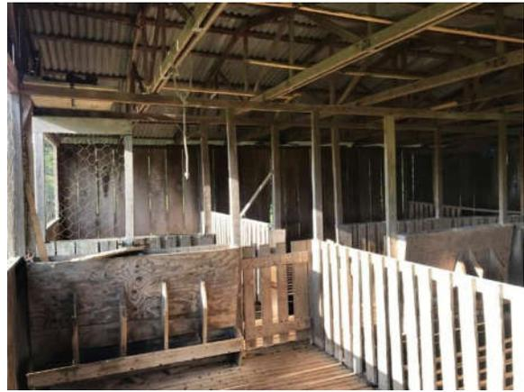
Um Telheiro com área total de 124,57m<sup>2</sup>, sem fechamento com paredes, sem piso, coberto com telhas de fibrocimento, em bom estado de conservação.
