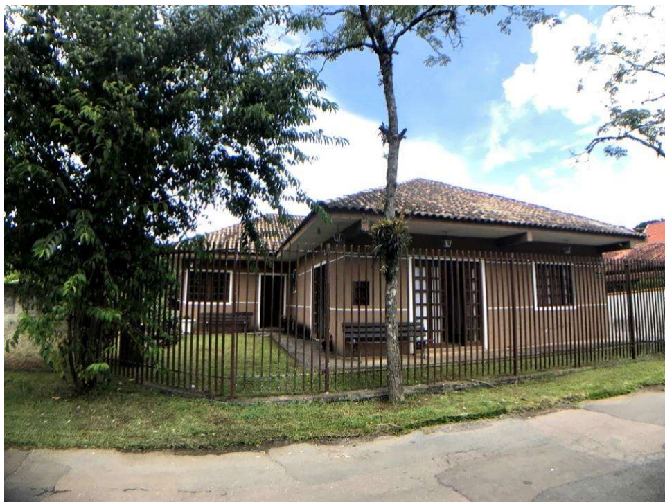
Imagem da fachada do imóvel avaliando
