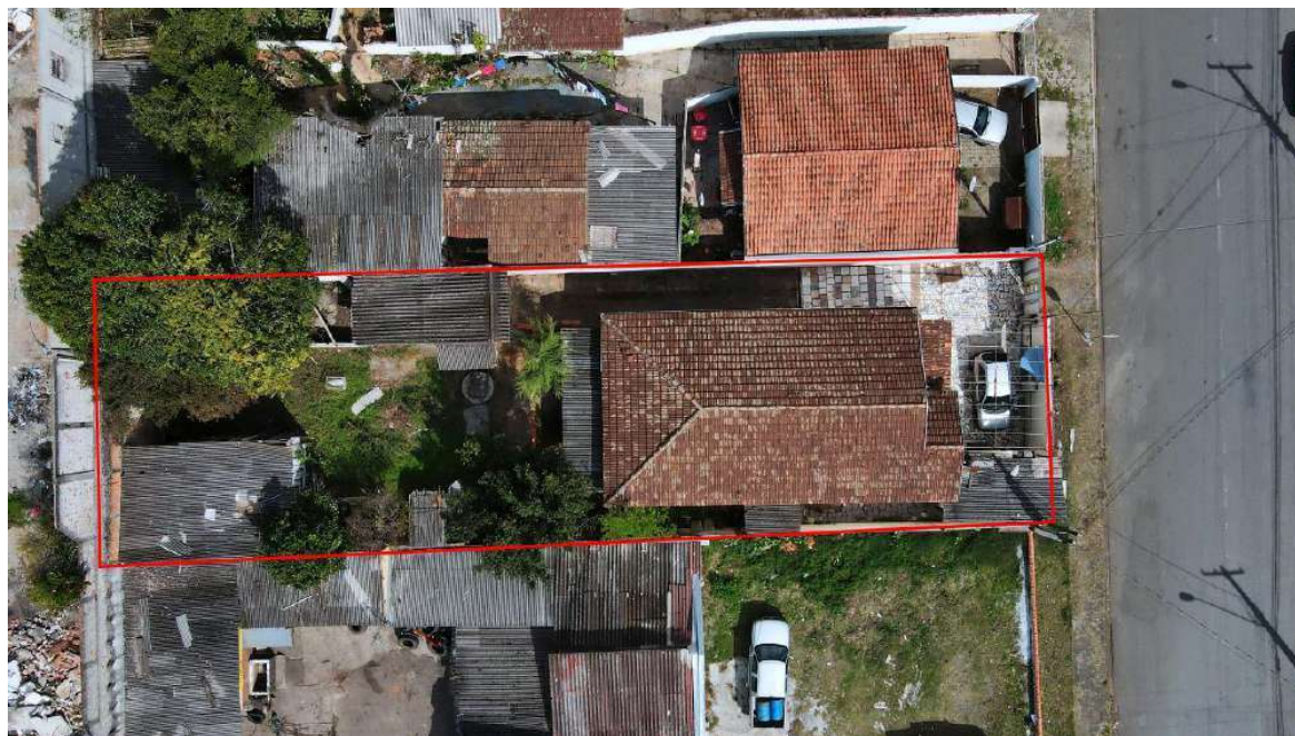
VISTA AÉREA SUPERIOR DO IMÓVEL
