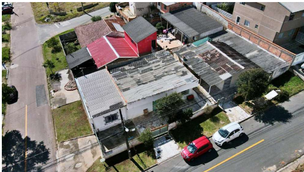
VISTA AÉREA DO IMÓVEL EM PERSPECTIVA
