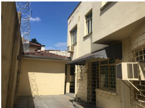
Foto 5 – Vista lateral do imóvel
