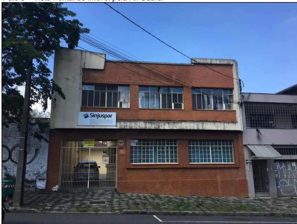
Foto 3 – Vista frontal do imóvel pela Al. Cabral
