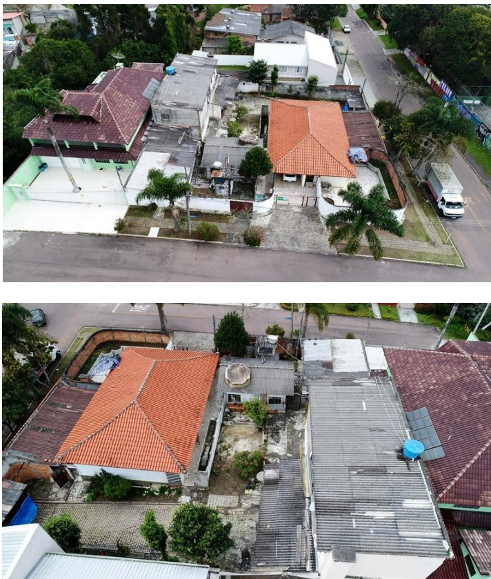
Imagem frontal superior e traseira superior do imóvel avaliando.
