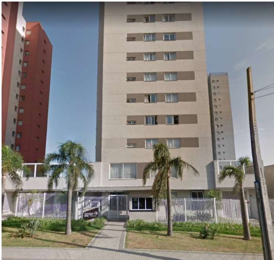
Imagem da fachada do condomínio dos imóveis avaliando.
