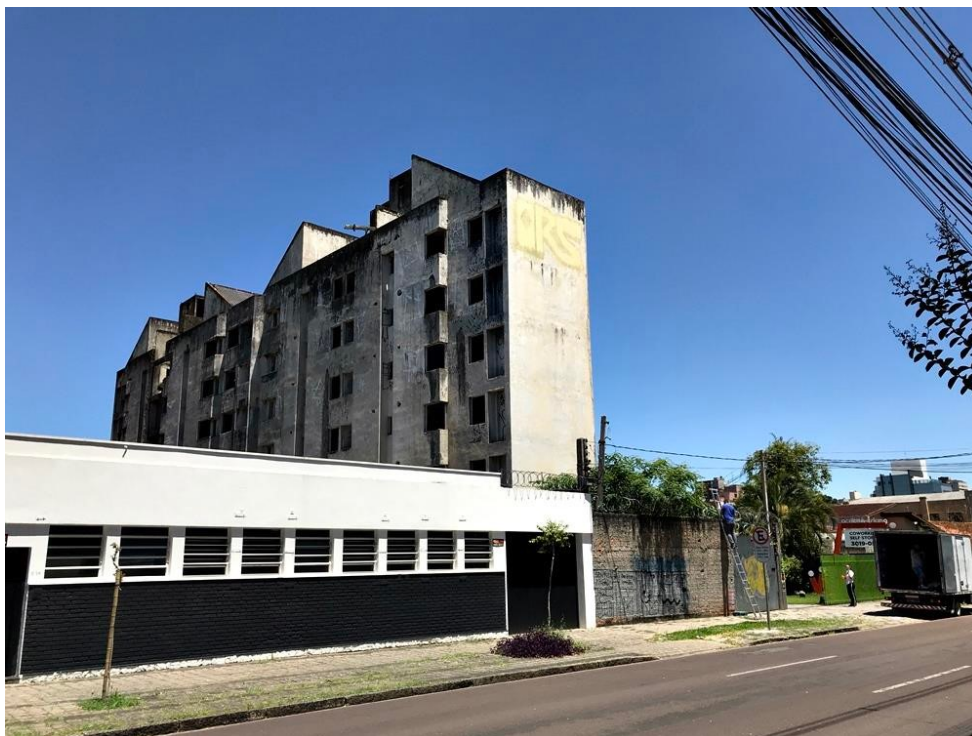
Imagem aérea do edifício, em construção, em que se encontram as unidades penhoradas
