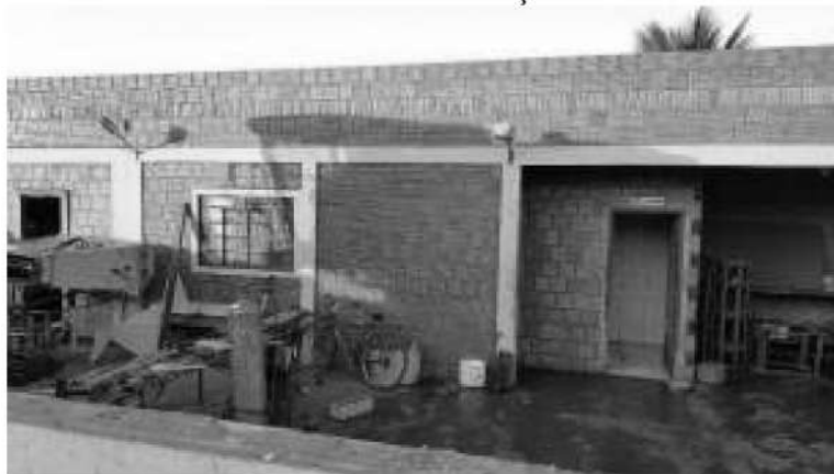
Parte da fachada da construção comercial
