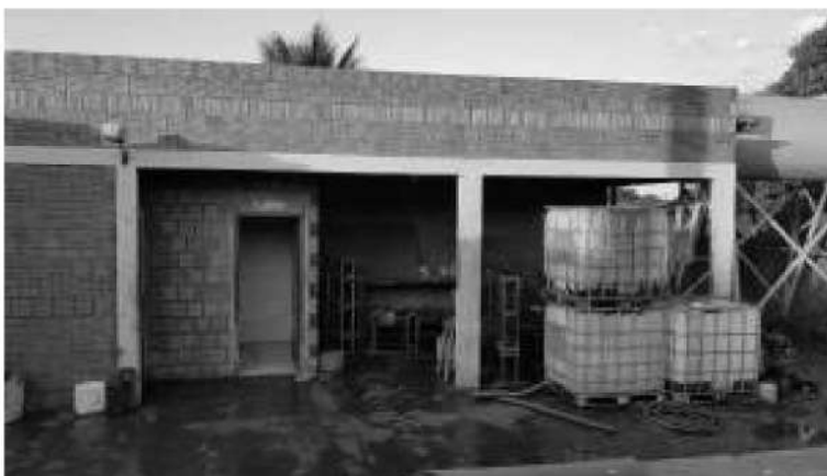
Parte da fachada da construção comercial
